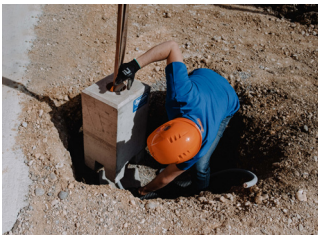
5. Versetzung des Fundaments und Einziehen des Kabels
