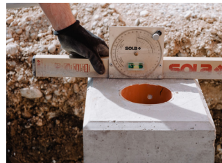
6. Waagrechte Ausrichtung kontrollieren
