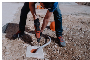
8. Bohrungen für die Montageplatte setzen
