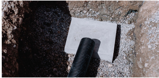
4. Leerrohr zum nachträglichen Einziehen vom Kabel oder direkt per Erdkabel
