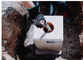
5. Versetzung des Fundaments und Einziehen des Kabels
