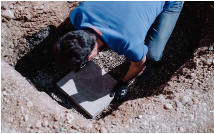
3. Basis-Betonplatte waagrecht ins Niveau einrichten
