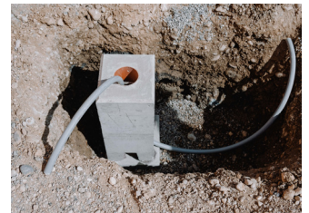
6. Waagrechte Ausrichtung kontrollieren
