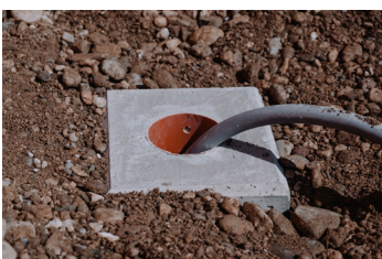
8. Bohrungen für die Montageplatte setzen
