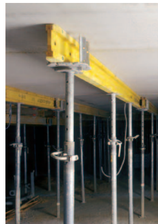
Bild 3 und 4: Montageunterstellung
