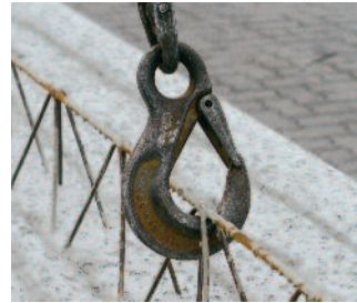
Bild 5: Kranhaken in Knotenpunkten der Gitterträger einhängen
