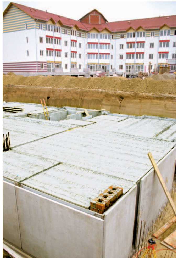
Bild 17: Elementdecke auf Großkeller
