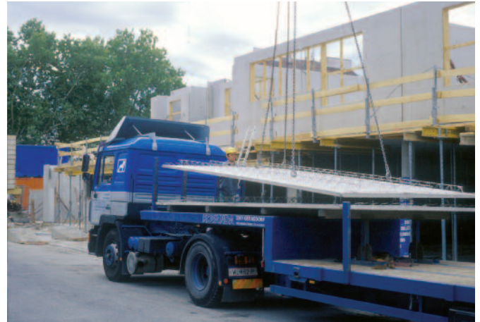
Bild 14: Abladen der Elemente
