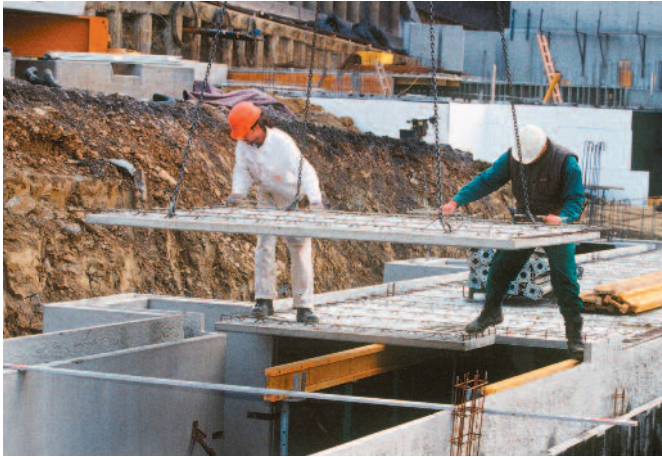
Bild 15: Verlegen der Deckenelemente
